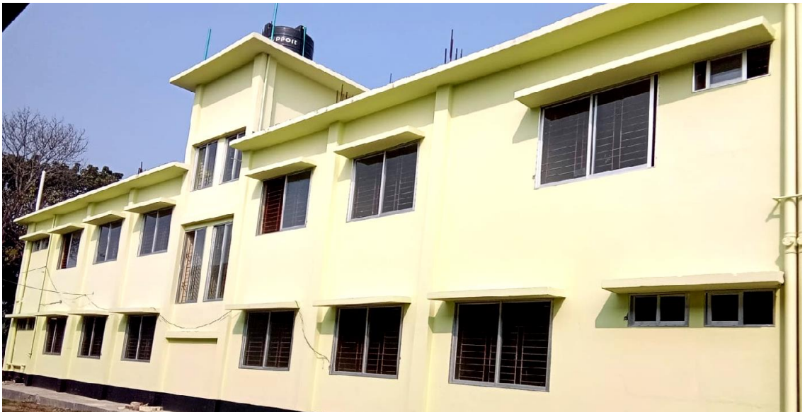
চিত্র-১৪: অফিস ভবন নির্মাণ, মুলাডুলি সিএসডি, পাবনা
