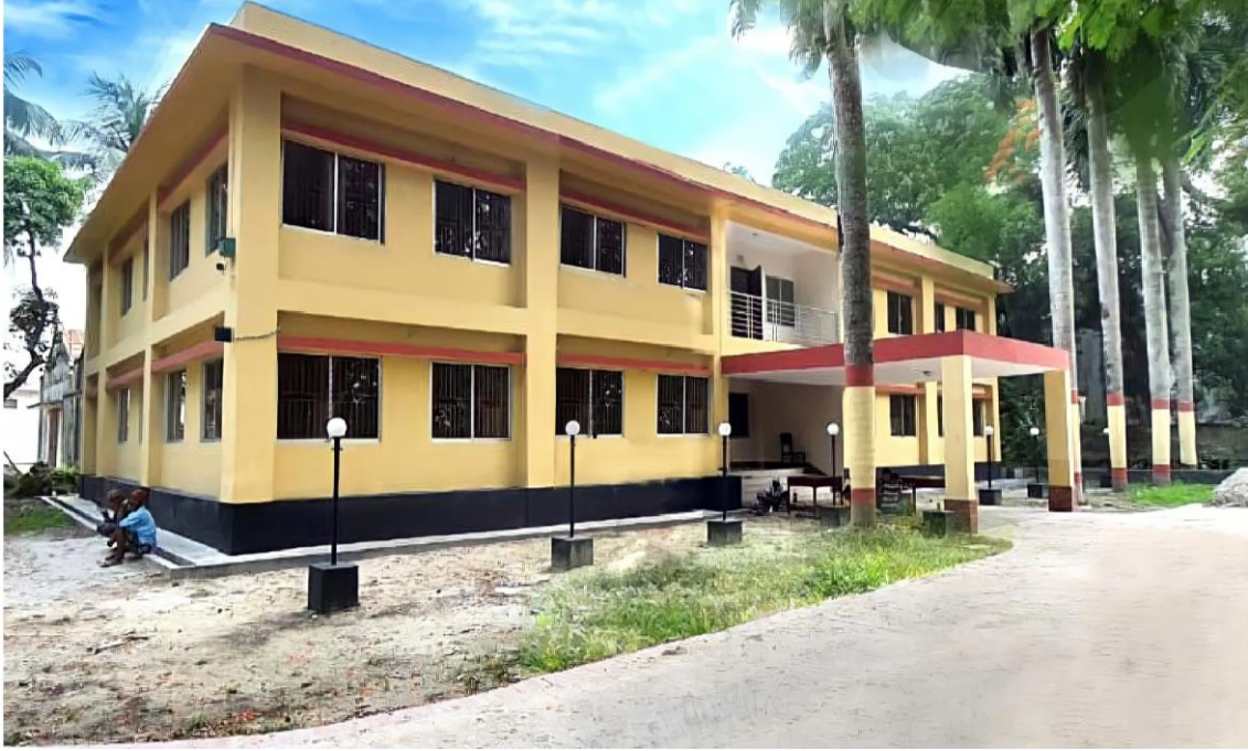
চিত্র-৭: অফিস ভবন নির্মাণ, ময়মনসিংহ সিএসডি, ময়মনসিংহ
