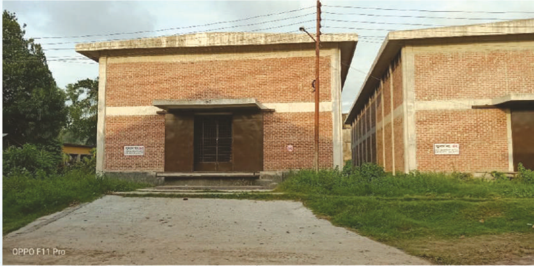
চিত্র-২৫: ১.০৫ লক্ষ মে. টন নতুন গুদাম নির্মাণ প্রকল্পের আওতায় দেওয়ানহাট সিএসডি, চট্টগ্রাম
