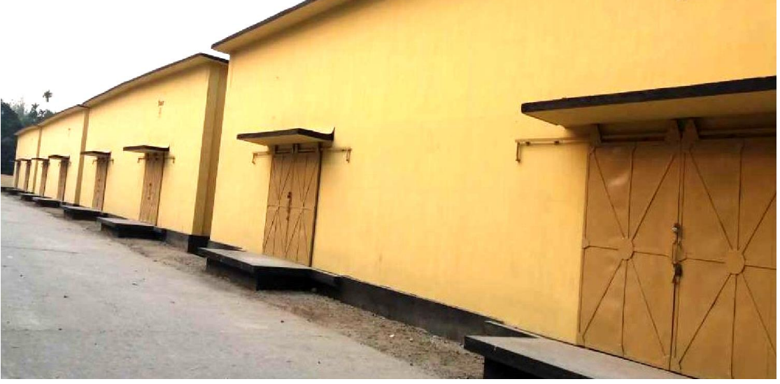
চিত্র-৭: খাদ্য গুদাম মেরামত, কুড়িগ্রাম সদর এলএসডি, কুড়িগ্রাম
