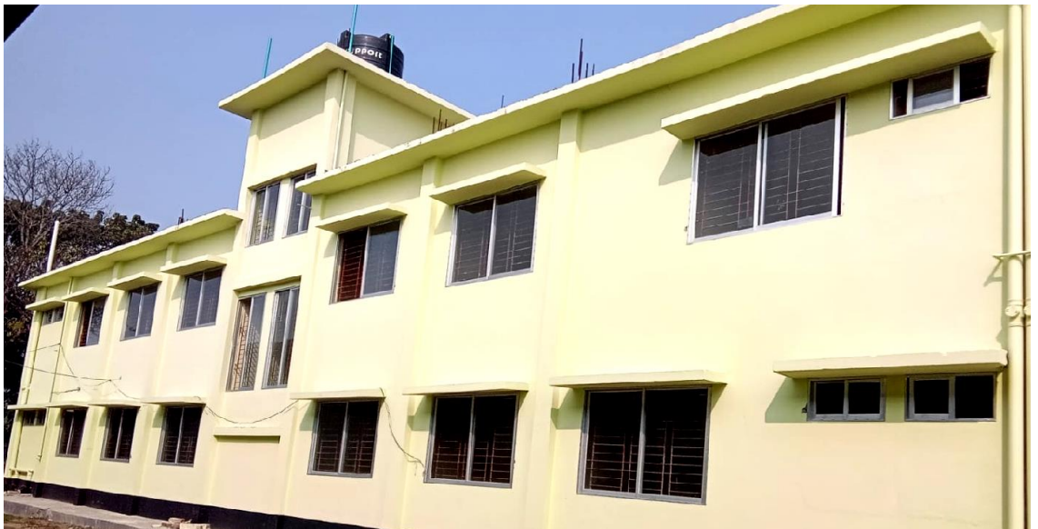
চিত্র-১১: অফিস ভবন নির্মাণ, মুলাডুলি সিএসডি, পাবনা
