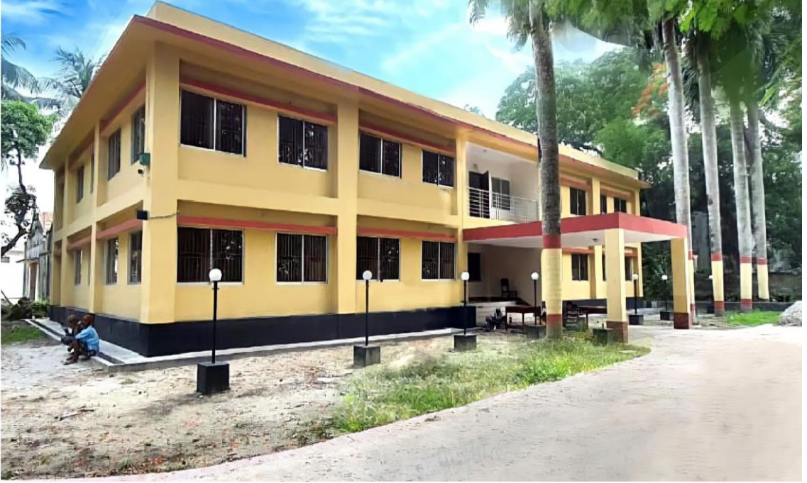
চিত্র-৪: অফিস ভবন নির্মাণ, ময়মনসিংহ সিএসডি, ময়মনসিংহ
