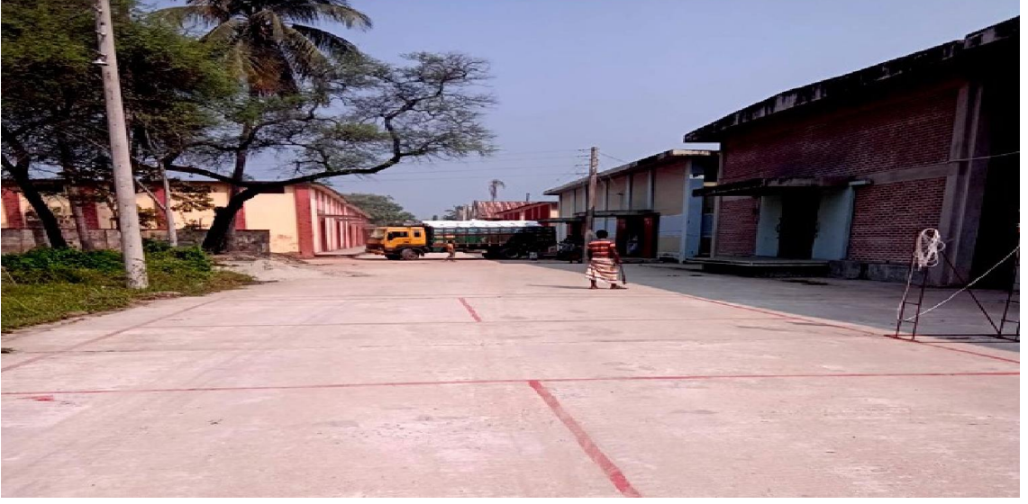
চিত্র-৬: অভ্যন্তরীণ আরসিসি রাস্তা নির্মাণ, মুলাডুলি সিএসডি, পাবনা
